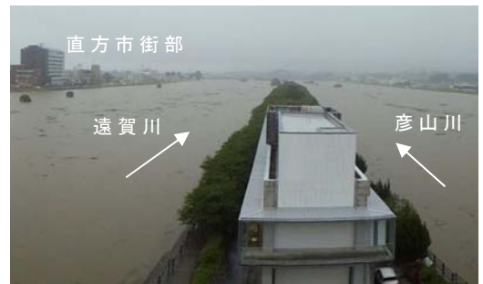
平成 30 年 7 月豪雨の状況 (遠賀川河川事務所屋上より)
